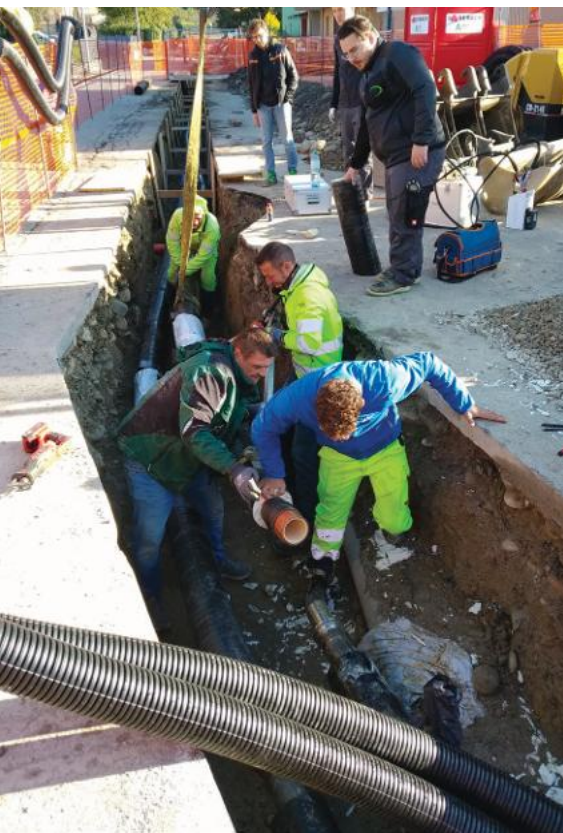
Connessione FibreFlex alle valvole di sezionamento (Dogliani)
