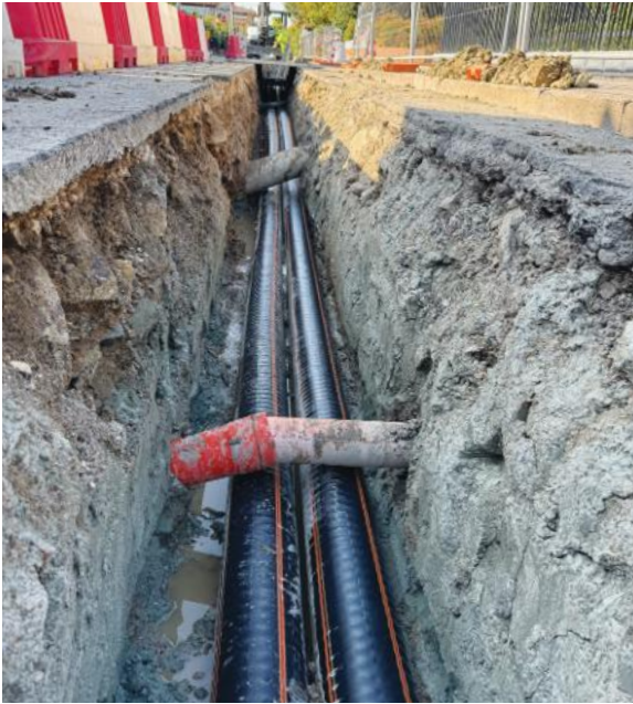
Superamento di sottoservizi (Montegrotto)
