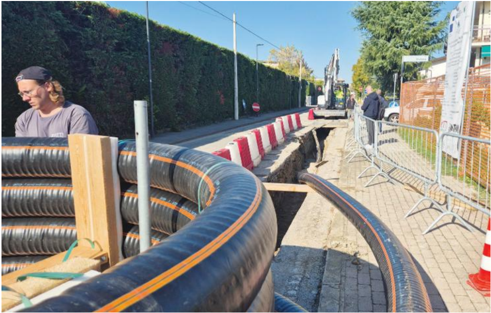
Posa del tubo (Montegrotto)
