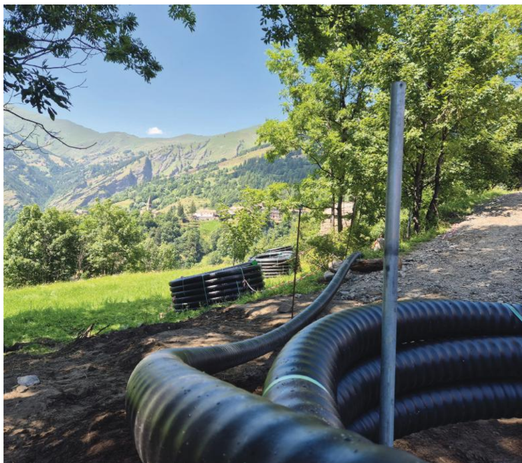
Posa del tubo (Elva)
